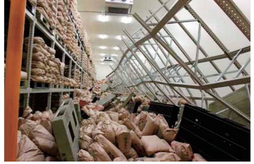
▶東日本大震災の地震により被害を受けた米の保管倉庫
